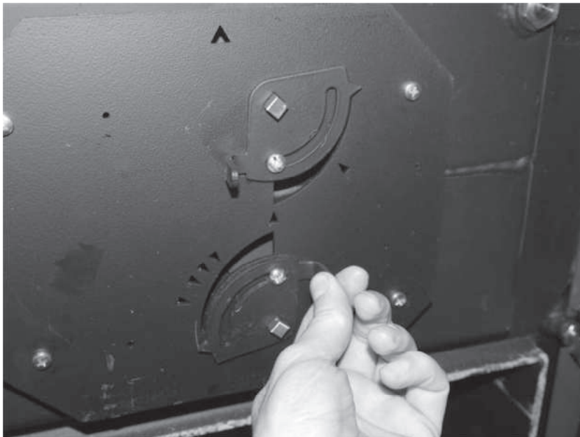
Nastavenie kotla DPX pre spaľovanie peliet (primárna a sekundárna klapka uzatvorená).
